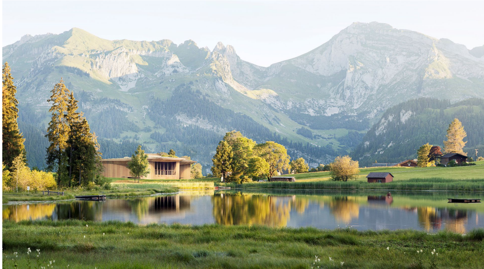
Klanghaus Toggenburg → Abschluss der Bauarbeiten
