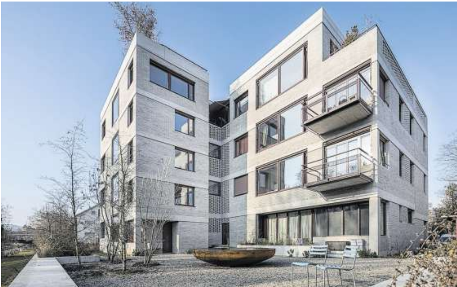
Rückseite des Hauses: Hier gibt es einen Regenwasserbrunnen und einen Grillplatz.
