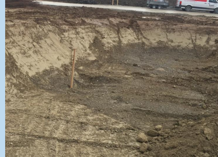
Quelle: Grundbauberatung AG
